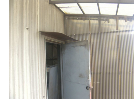
現況写真[工場外部]
