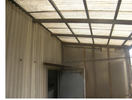
現況写真[工場外部]
