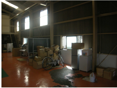
現況写真《工事前状況》
