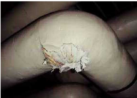
アスベスト含有配管保温材 (配管)
