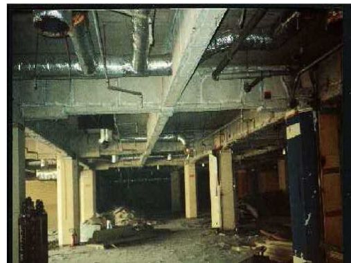
アスベスト含有けい酸カルシウム板第2種 (梁)
